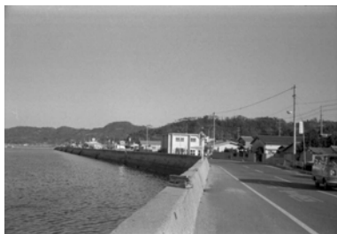
この後、さらに埋立がすすむ 昭和 51 年 12 月
