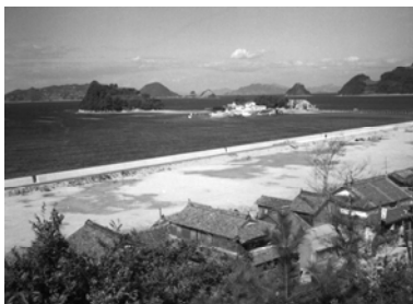
干潟を埋め立てて車道をつける 昭和 38 年 10 月
