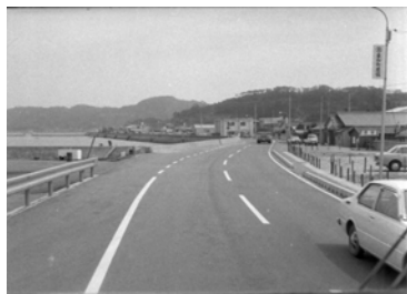
車道が完成する 下田付近 昭和 51 年 4 月
