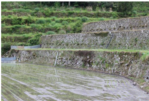
(上) 周南市 井谷「足かけ」の付けられた見事な柵田石垣。 (下段パイプより手前法面の石組みに、他との違いが見られる)
