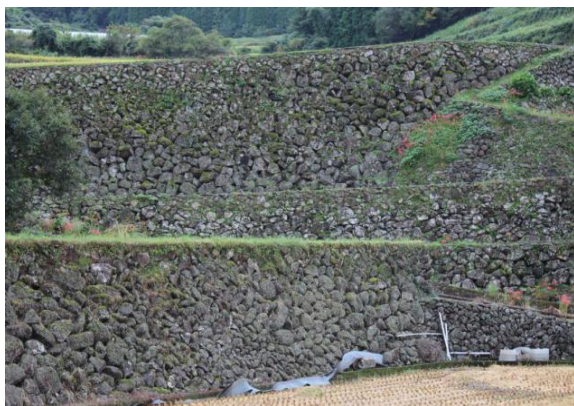
唐津市 日本の棚田石垣で最も高いうちのひとつと言われる蕨野(わらびの)棚田石垣。高さ8.5メートル。昭和の初め10年の歳月をかけて築かれた。野面石のため法面に隙間があり 作業用足場が確保されている。一部飛び出した足場石もある。 (日本の棚田百選)
