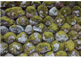
うきは市の 清水寺の布積 見事な石垣 積み（玉石 積み）
