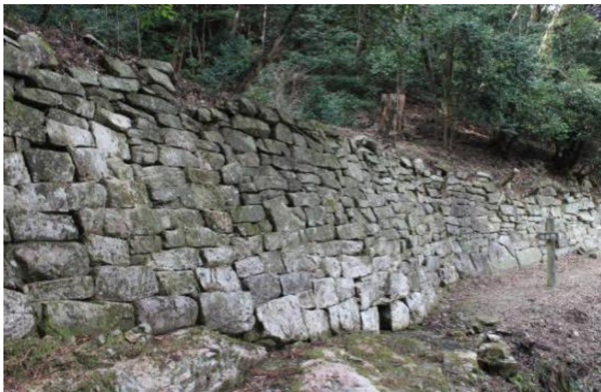
（上）光市 石城山神籠石（下）山口市宮野 平積みに石材を組んだ棚田の石垣。本レポートでは何れも「布積み崩し」として分類。
