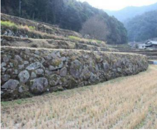
垣田石田の兼久市防 垣上積み「乱積み」石 石の野面を取り込んだ 野面石の「乱積み」石 垣。
