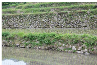
周防大島町 「谷積み」による新しい石垣（上段）と半土坡による「布積み崩し」の古い石垣（下段）。
