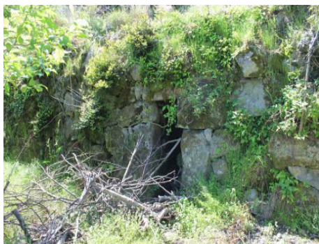
周防大島町 久賀 石原田の水道 「足かけ」とともに棚田構 築の工夫である。
