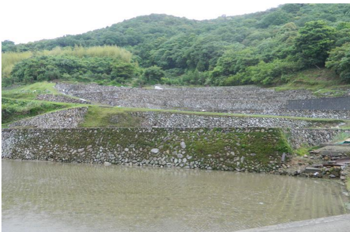
周南市 山口県棚田20選に選ばれた四郎谷地区の棚田石垣。 「足かけ」は無く、上辺部が石できれいに縁取りしてあるのが印象的。
