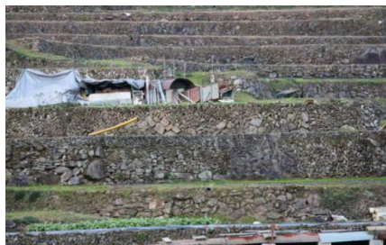
(上) 周南市 井谷「足かけ」の付けられた見事な柵田石垣。 (下段パイプより手前法面の石組みに、他との違いが見られる)
