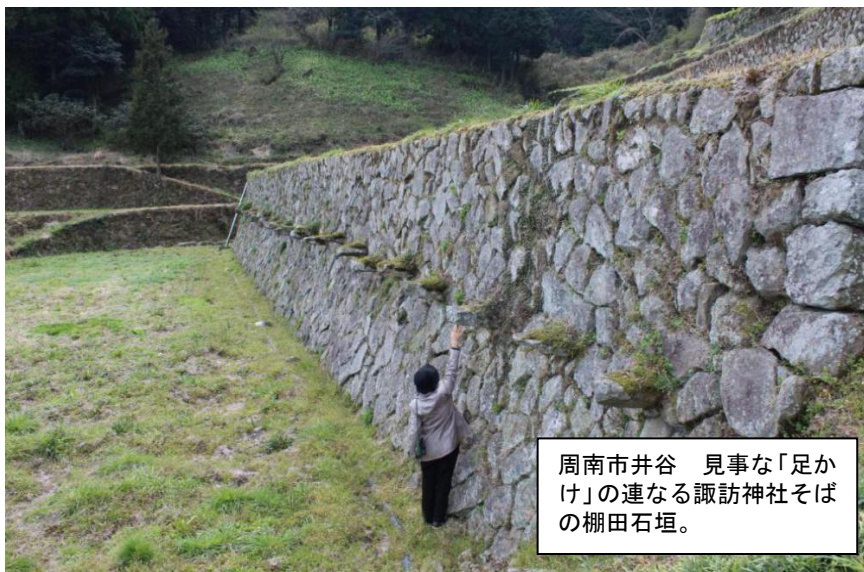
NHK テレビ番組より、水量を分散して水害を最小限に食い止めた石垣棚田。
