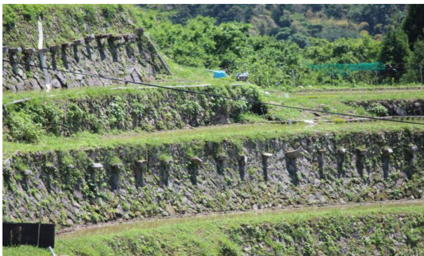
周南市 小畑の「足かけ」と谷積みによる見事な石垣法面。
