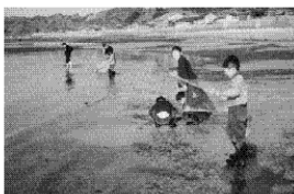
熊本の山で子供たちが遊ぶ。沿岸の改修工事により砂浜は増えた。 昭和32〜33年（1957〜58）
